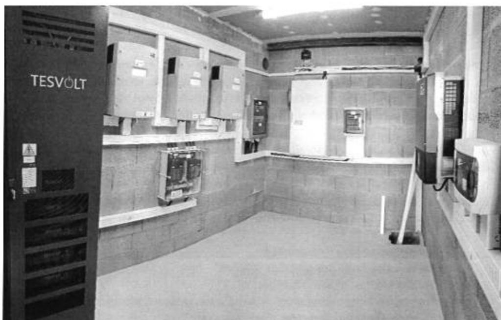
Figure 5 : Système de stockage de l'énergie électrique de 48 kWh et 13 kW installé dans un bâtiment.
