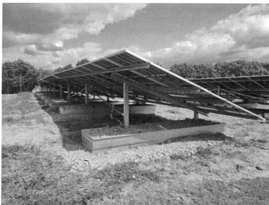
Figure 3 : Exemple de structure métallique support des modules solaires avec gabions.
